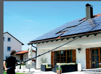
Rengjøring av solcellepaneler
